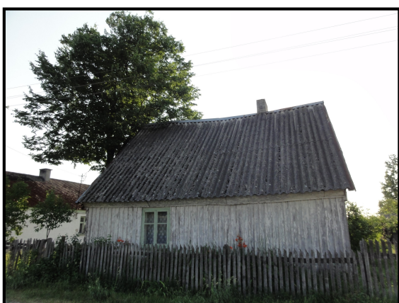
fot. 6. Dom drewniany w Oknach (źródło własne)
